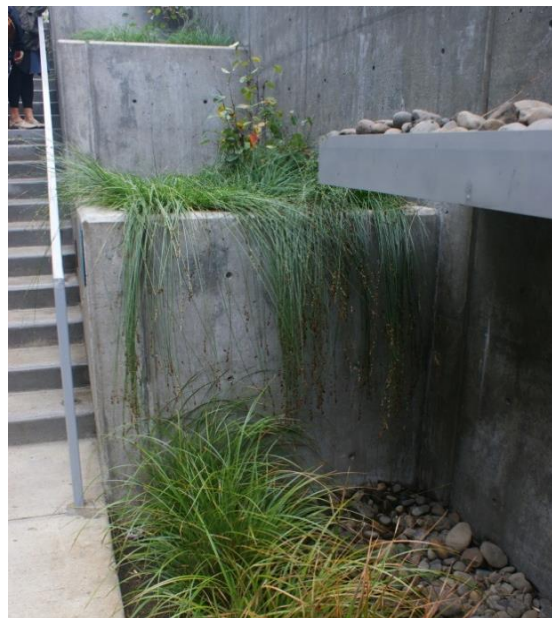
Avvattning av terrasserade innergårdar med hjälp av planteringar, rännor och överfall.
