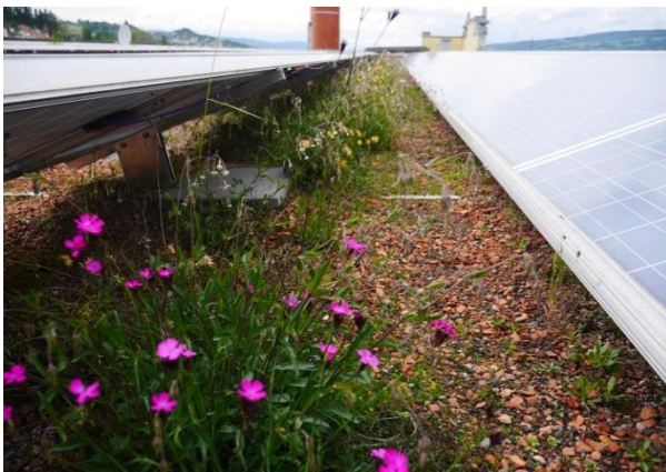
Grönt tak i kombination med solceller.
